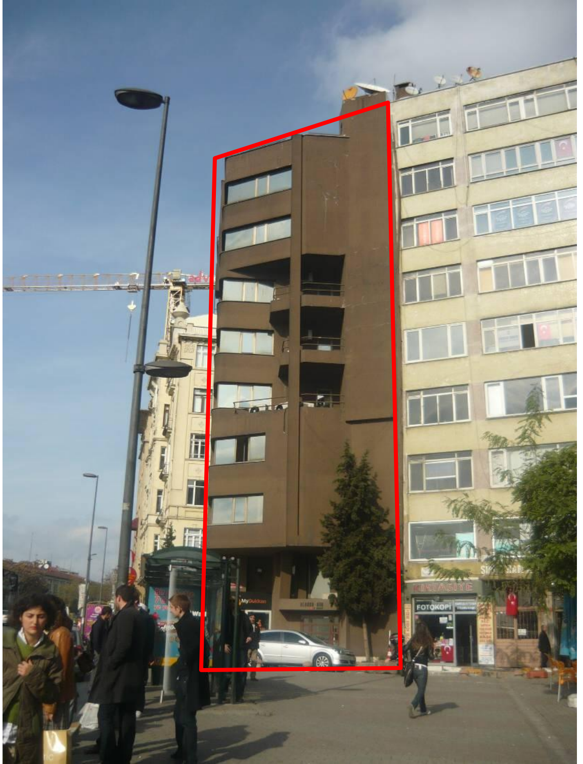
Taşınmazların yer aldığı binanın görünümü
